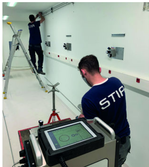
Abb.2: Installation von Rohrleitungen für medizinisches Gas in einer Klinik. / Fig.2: On-site installation for medical gas lines in a hospital. Abb.3 Station:
